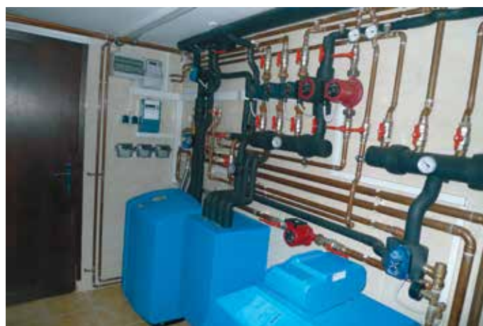
Ogrevanje prostorov (radiatorsko) in bazena + pasivno hlajenje
