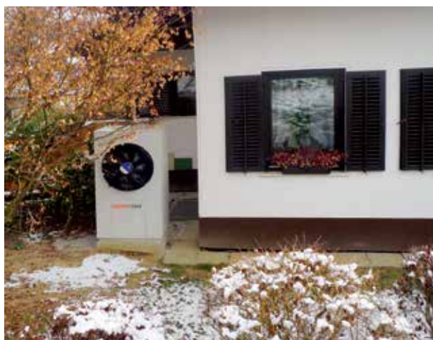
>> Hiša v celoti ogrevana s supervarčno TČ, povezava na računalnik in celoletno beleženje obratovalnih podatkov
